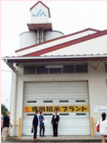
250t×8基のサイロをもつカントリーエレベーター
